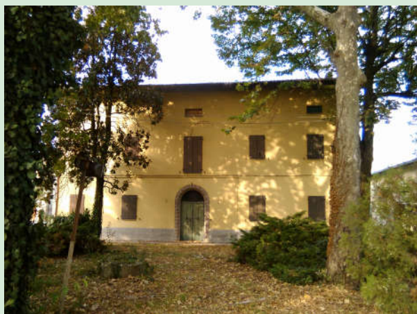
La casa da ristrutturare
