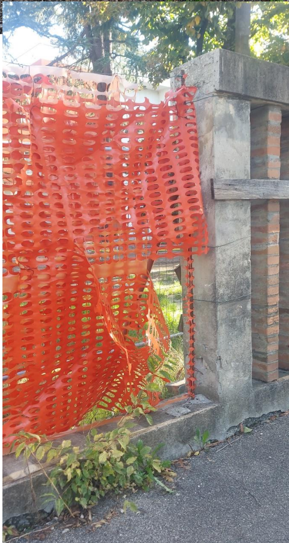
La recinzione in Piazzale Gramsci il 29/09/2024
