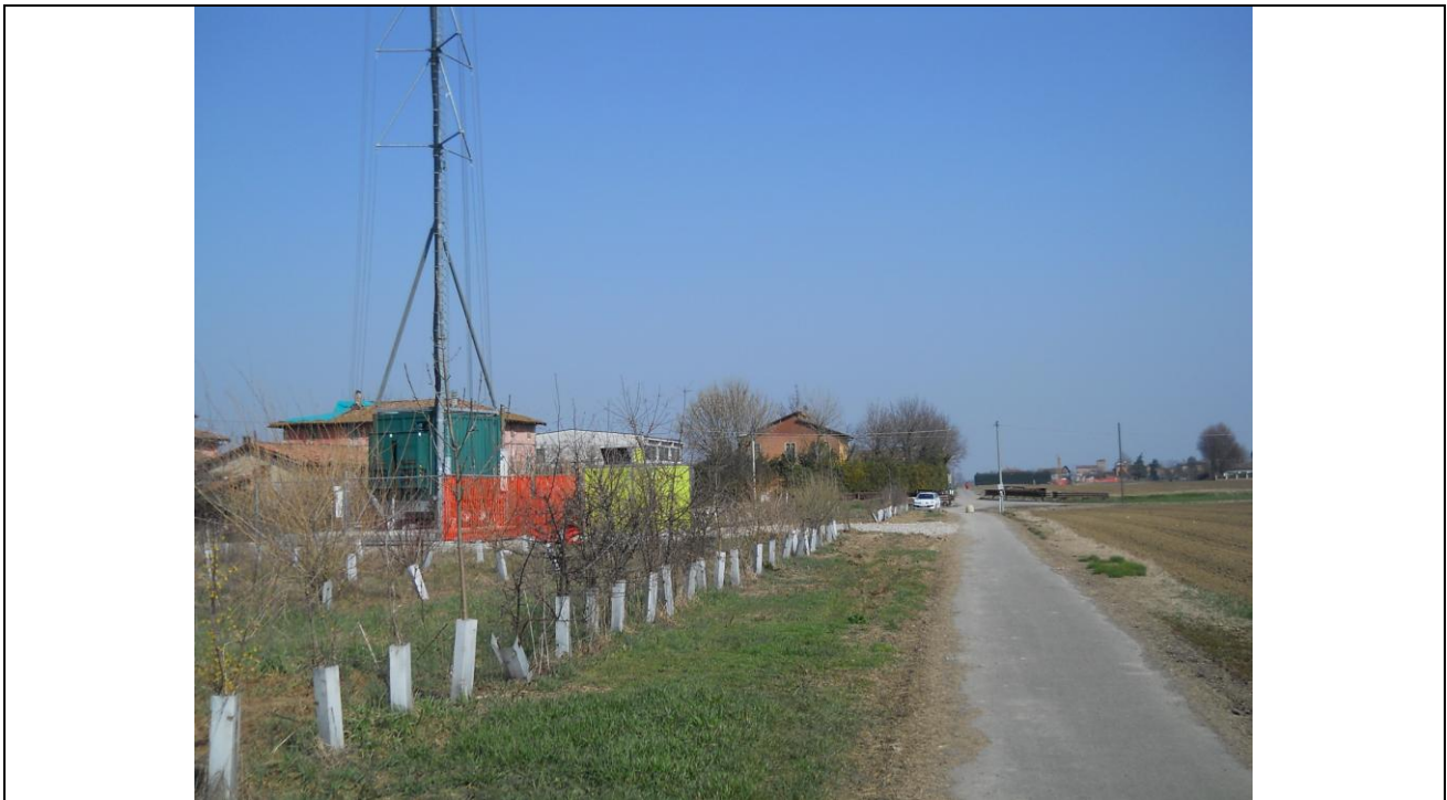
Foto dell'area sede della nuova installazione
