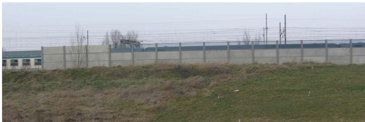
Figura 49 – Linea ferroviaria barriera esistente e linee elettriche di servizio
