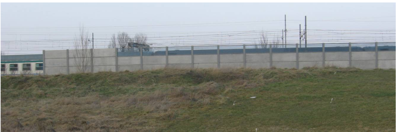
Figura 26 – Linea ferroviaria barriera esistente e linee elettriche di servizio
