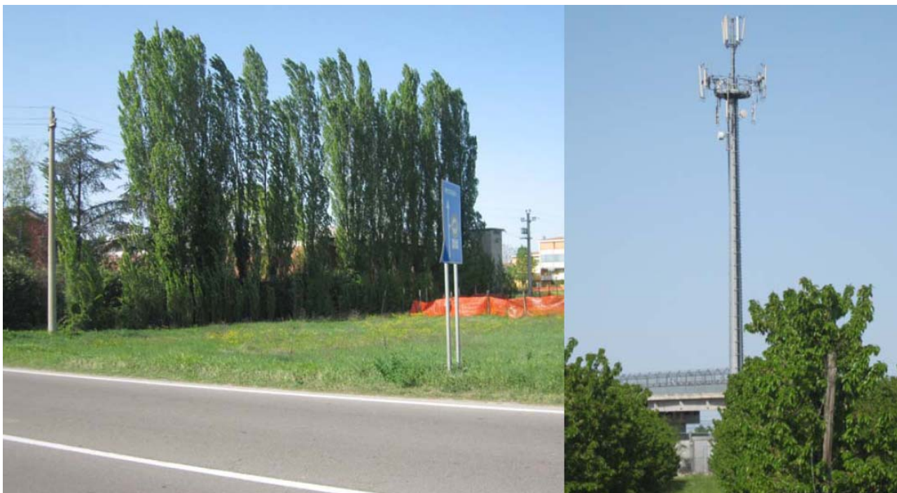
Figura 52 – SRB vicino alla ferrovia ed elettrodotto aereo esistente
