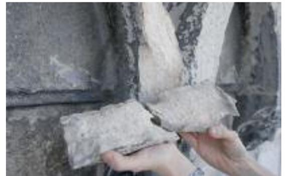
Fig. 1 - Esempio di degrado del materiale lapideo di rivestimento della torre Ghirlandina prima del restauro (pietra di Vicenza), causato dall'impiego intensivo di resine epossidiche.
