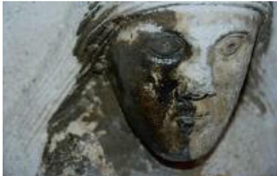
Fig. 2 - Esempio di pulitura del volto della sirena (prima cornice lato nord, pietra di Aurisina) eseguita in modo selettivo, prima con vapore a bassa temperatura, tensioattivo, poi completandola con tecnica laser, modalità che hanno consentito la conservazione delle patine di caseina in parte ancora presenti sulla superficie.
