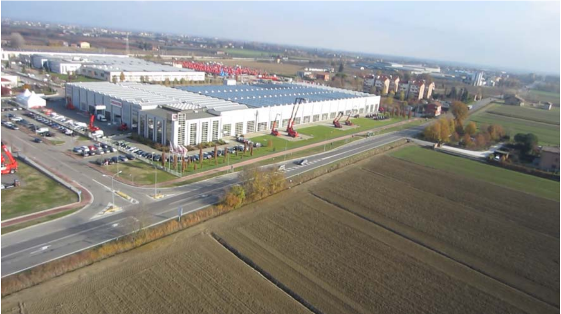
AEREA VERSO NORD-EST.
