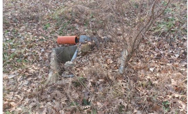
*Esempio di pozzetto con copertura divelta*
