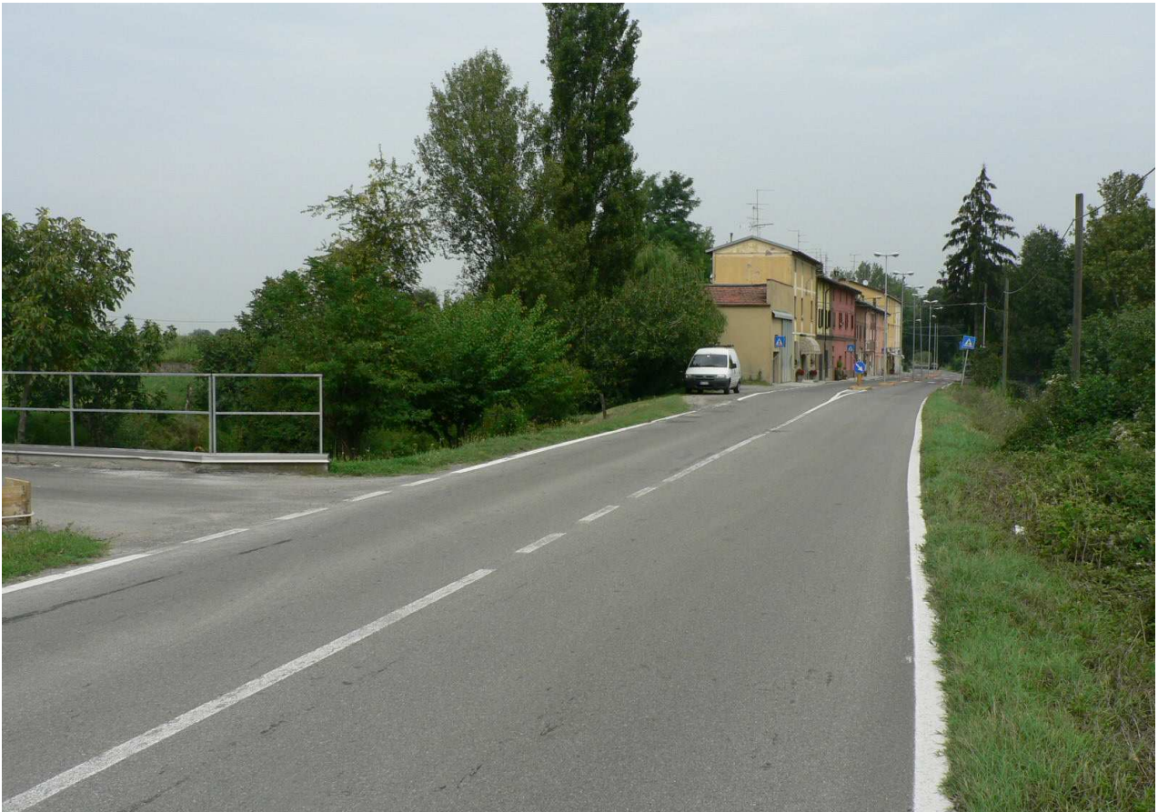
Fig 1 –punto in cui verrà realizzata la rotatoria sud (nodo 2); in alto sul lato sinistro della strada sono visibili gli edifici dell’abitato della frazione California.
